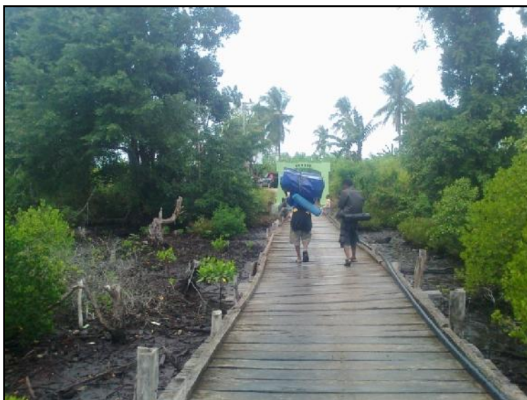
Gambar 11.2. Jembatan Pulau Osi – Pelita Jaya
