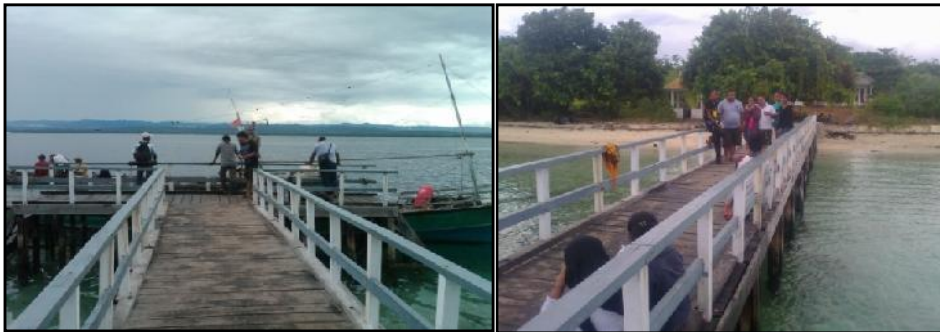
Gambar 11.3. Jembatan Pulau Marsegu
